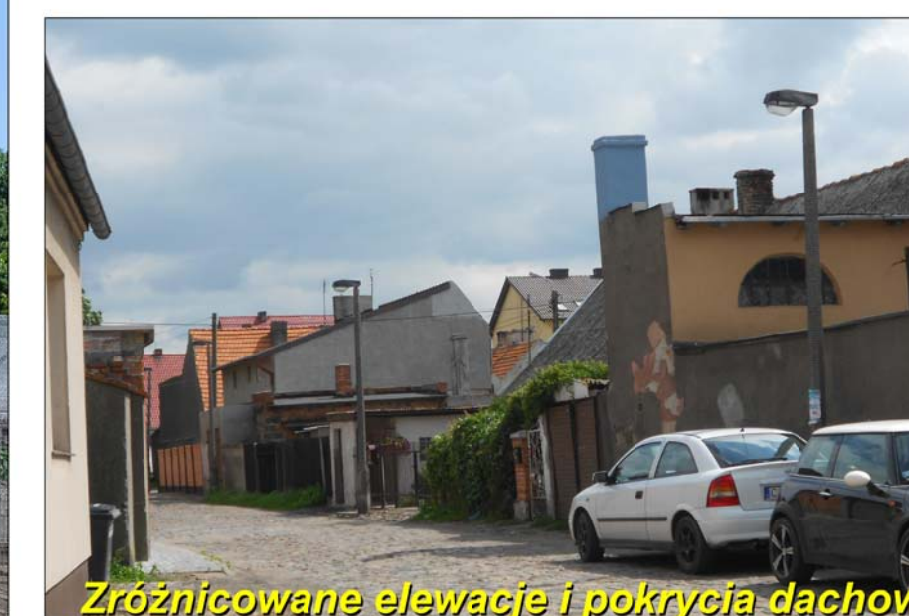
Różnicowane elewacje i pokrycia dachowe
